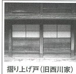
摺り上げ戸 (旧西川家)
