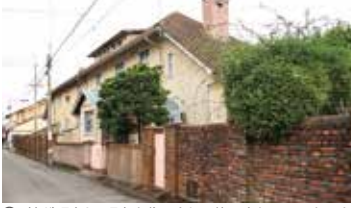
④4棟が現存し、現在も住居として使用されているものも
